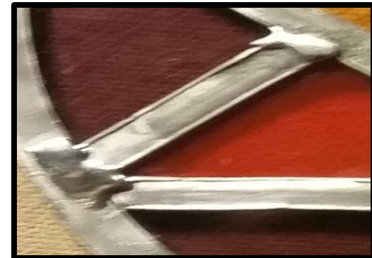
Ailes des armatures en plomb insuffisamment rabattues sur le verre
