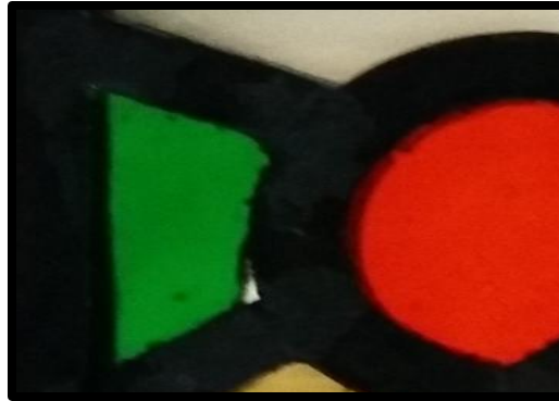
Verre insuffisamment ajusté au profilé de plomb
